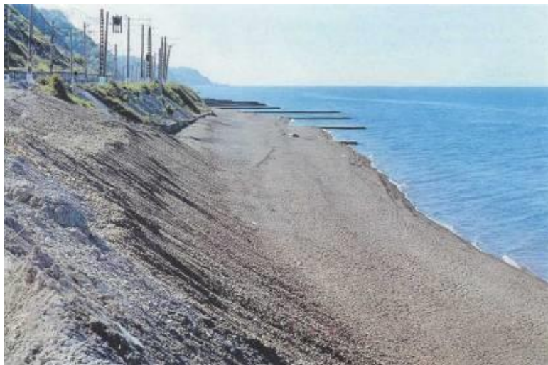
Рис.106. Создание искусственного пляжа путем отсыпки щебня и гравийно-галечникового материала
